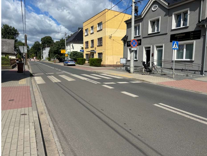
(lokalizacja przejścia dla pieszych – stan istniejący)
