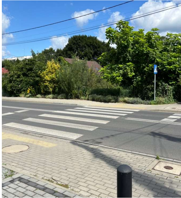
(lokalizacja przejścia dla pieszych – stan istniejący)
