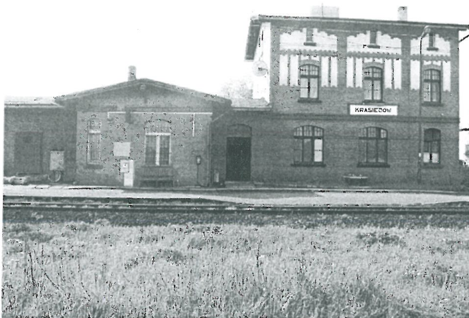
Zdj. 3. Stacja kolejowa- stan obecny.
