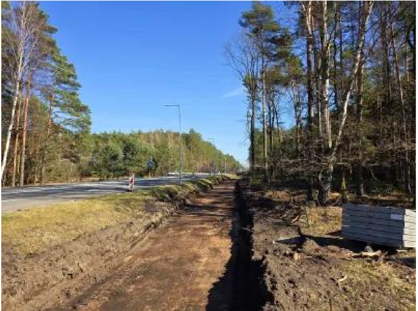
Trwają prace nad budową ścieżki pieszo-rowerowej
