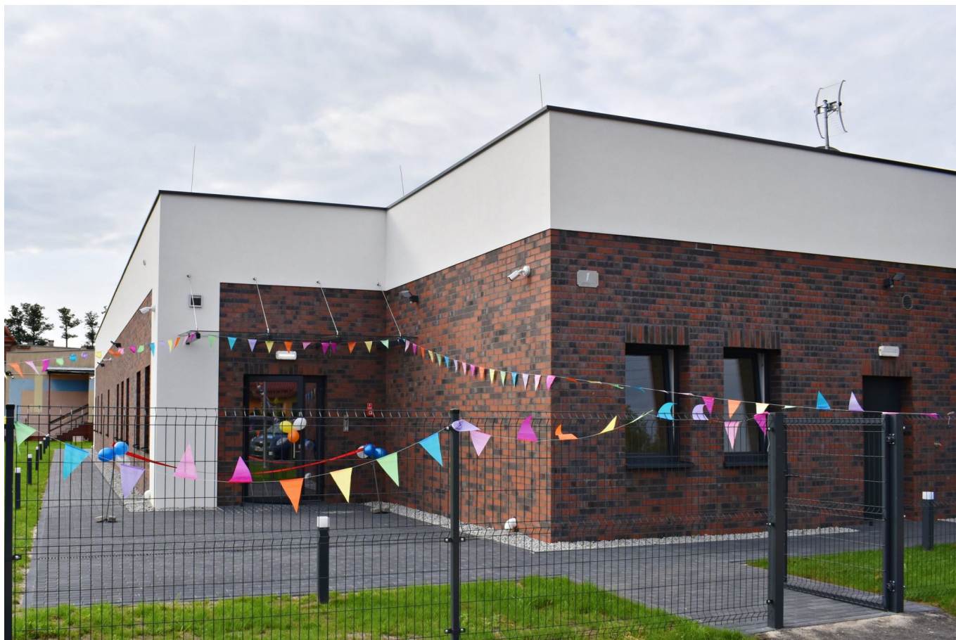
Na zdjęciu nowy budynek przedszkola w Grodźcu
