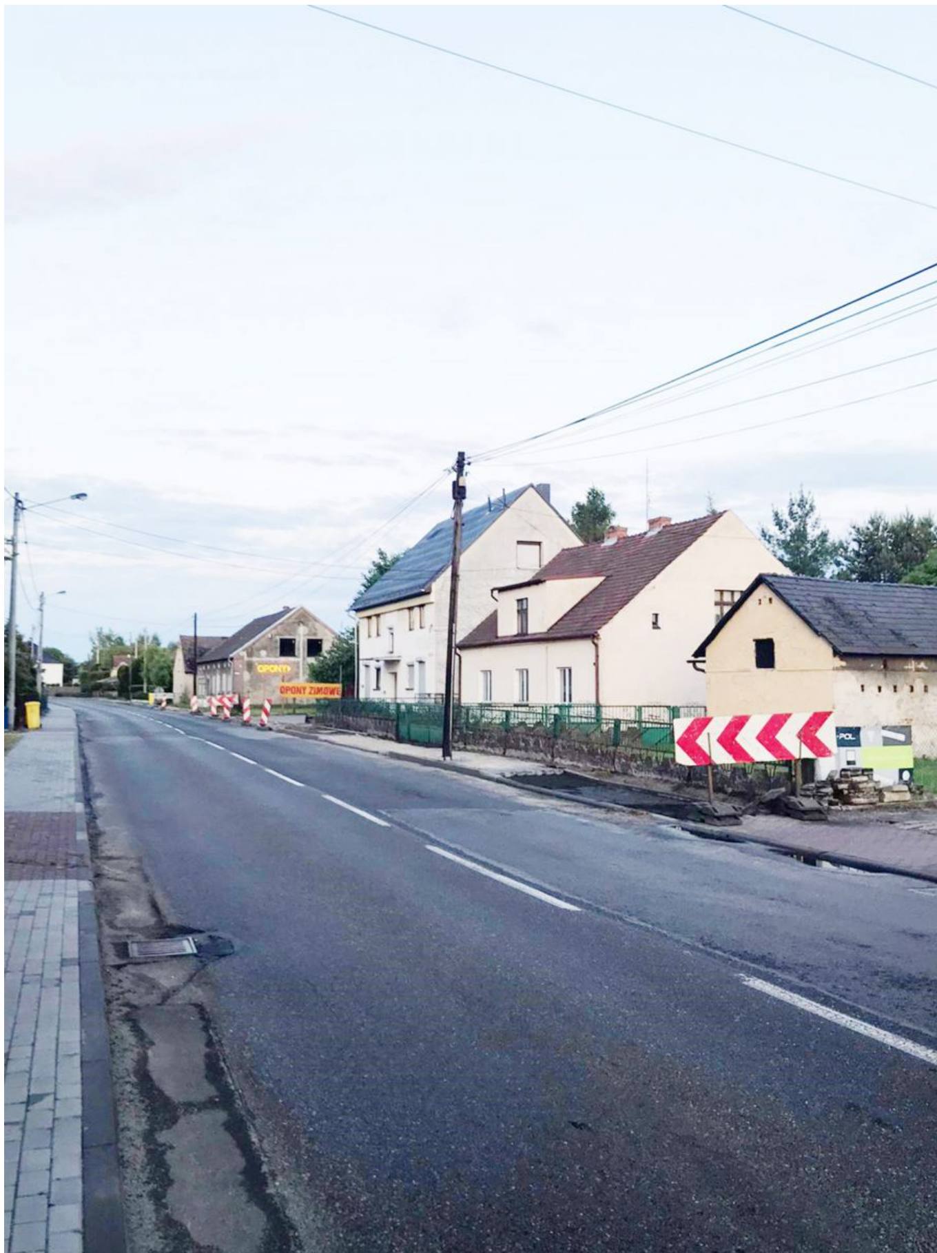
Remont chodnika wzdłuż ul. Wyzwolenia w Ozimku
