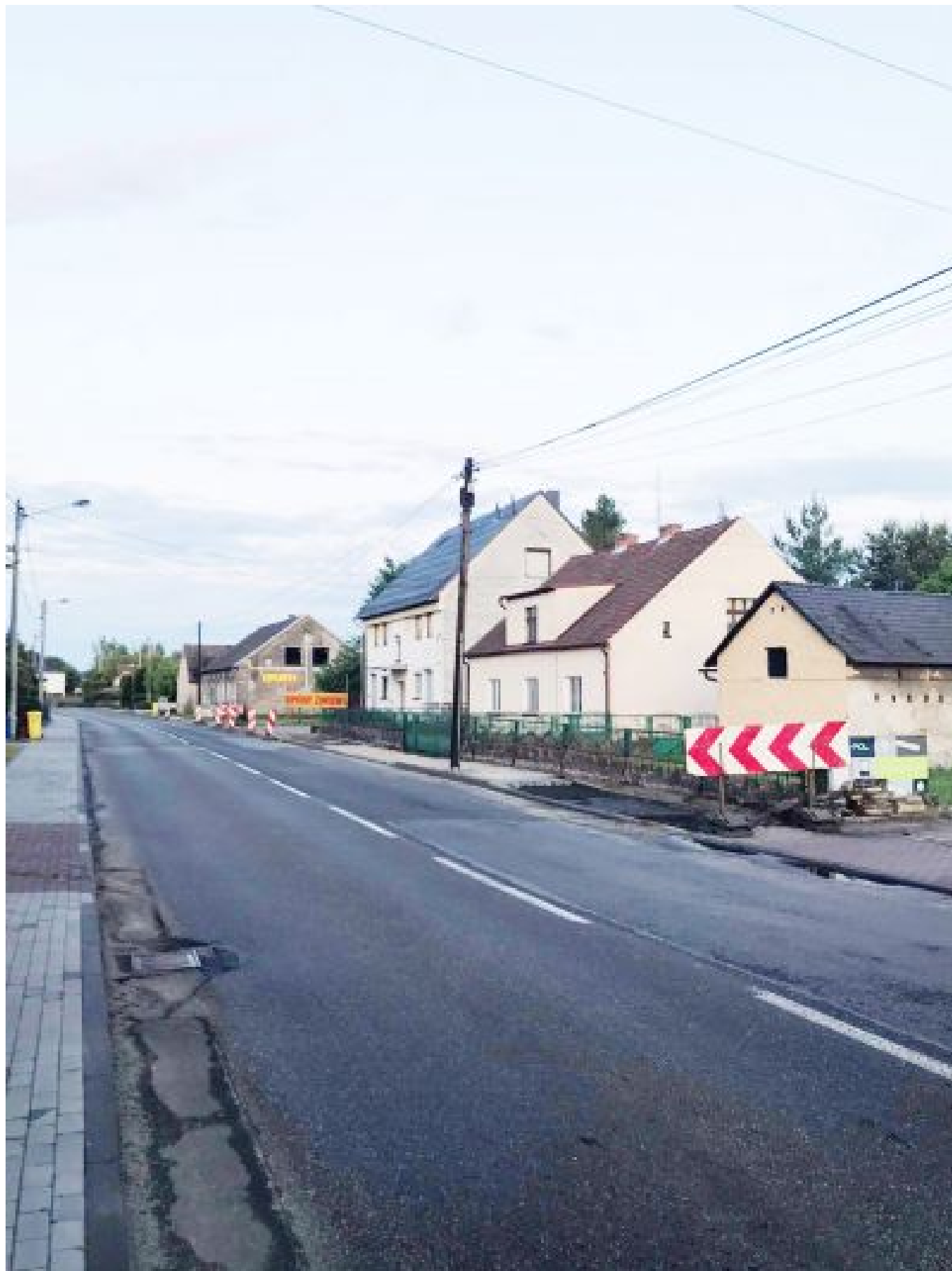
Remont chodnika wzdłuż ul. Wyzwolenia w Ozimku
