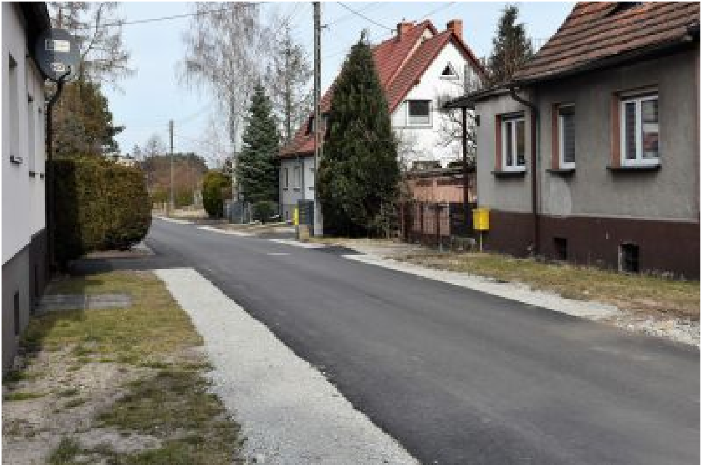
Modernizacja ulic Waryńskiego i Jelenia
