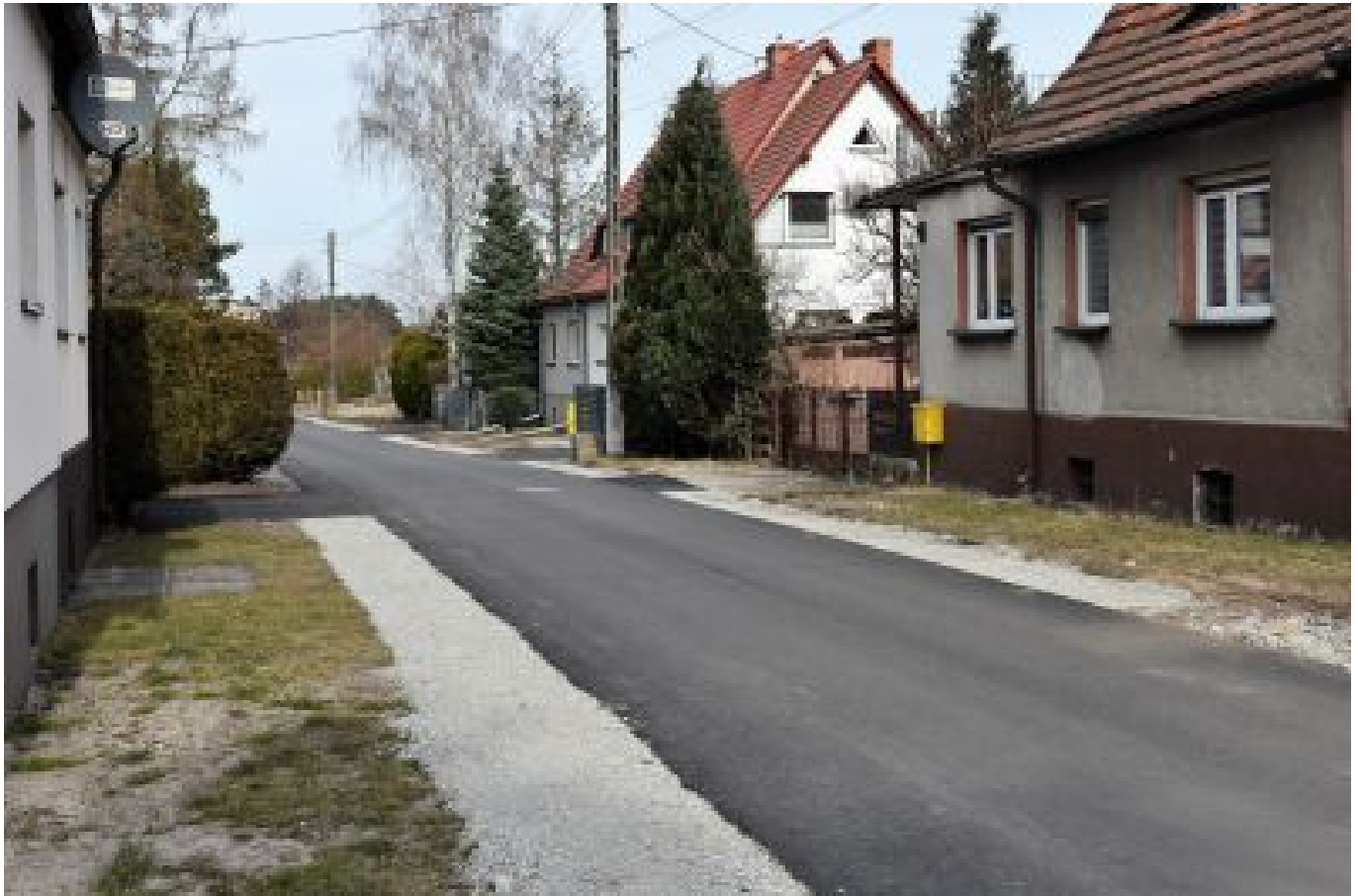
Modernizacja ulic Waryńskiego i Jelenia
