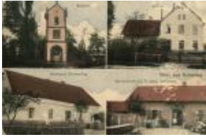
Schodnia początek XX wieku
