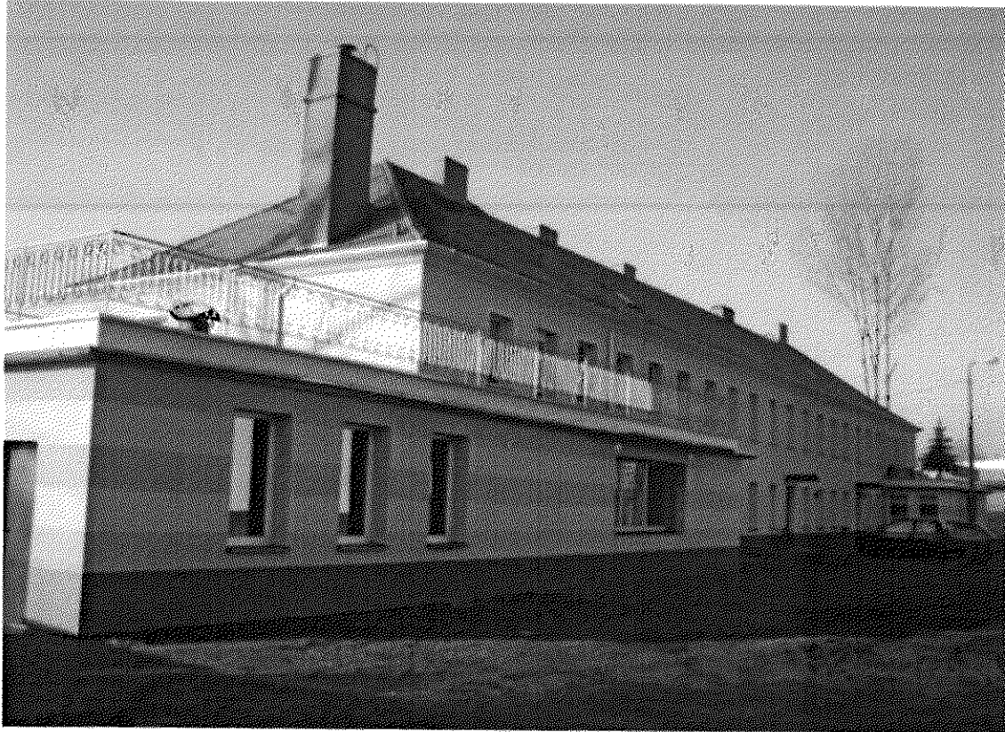
Kompleks użyteczności publicznej – przedszkole, biblioteka, świetlica wiejska i TSKN.
